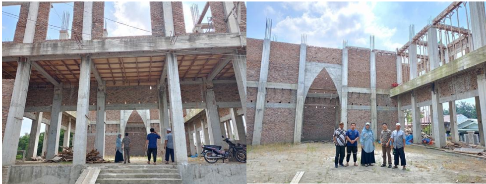
Gambar 1. Pembangunan di Masjid Al-Amin
