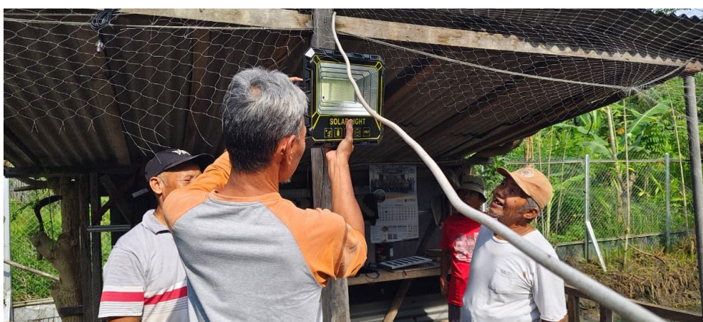
Gambar 4. Pelatihan pemasangan dan perawatan lampu solar panel
