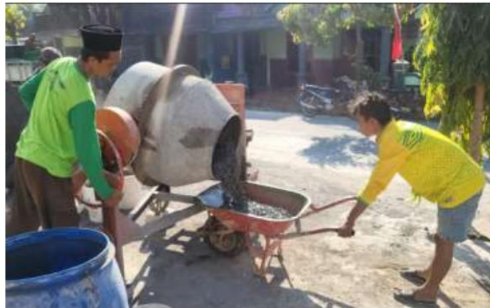
Gambar 3. Praktik pengecoran beton sesuai SNI
